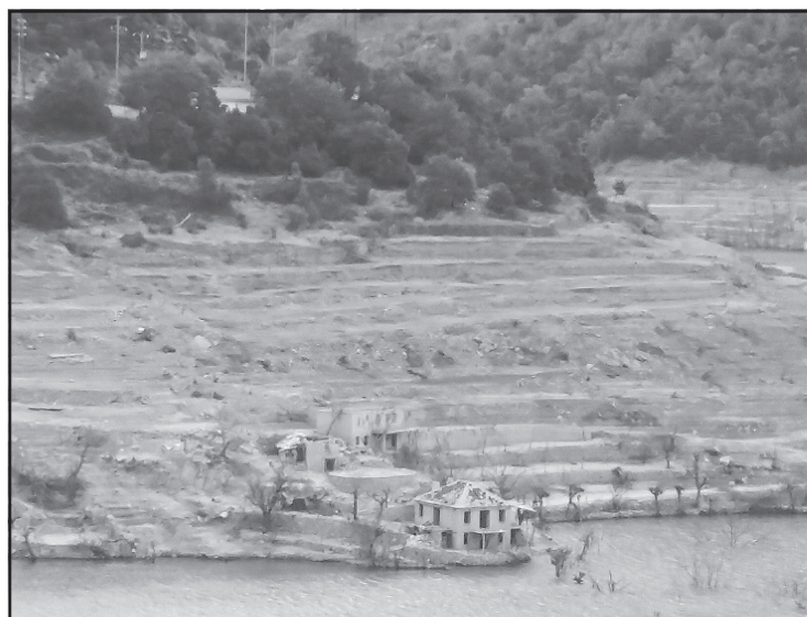
Η στάθμη της Ευηνολίμνης σε χαμηλό επίπεδο. Φάνηκαν τα Καλαθαίικα σπίτια.
