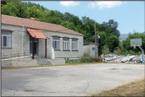
Το κτήριο του σχολείου μετά τα έργα και την κατεδάφιση της δεξαμενής.
