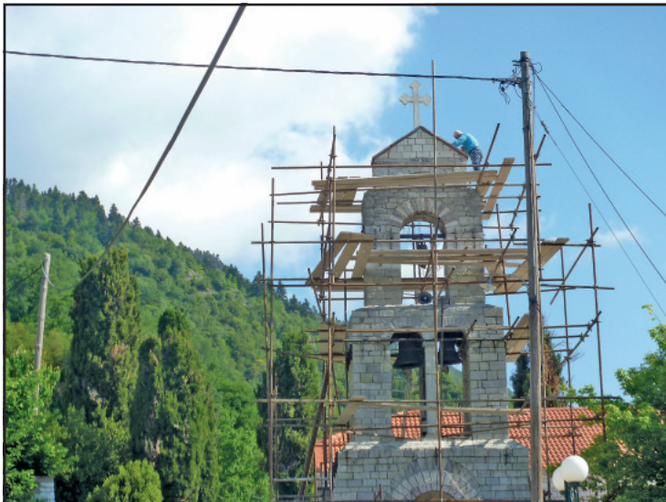
Εργασίες στο καμπαναριό.
