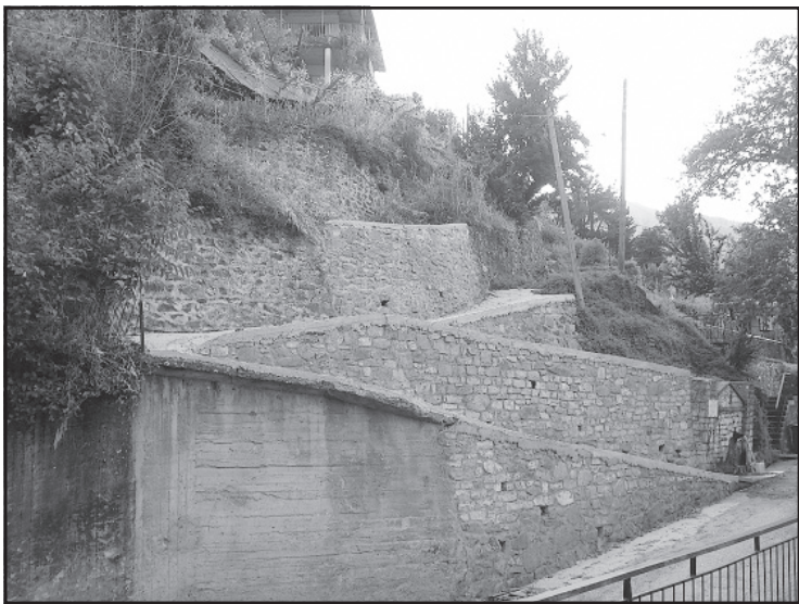
Οι μάντρες στου Κατσαούνη τη βρύση μετά τις εργασίες.
