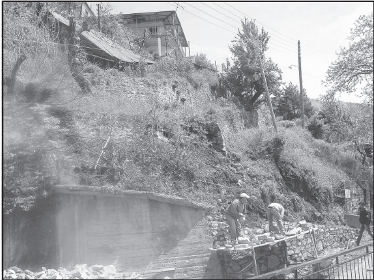
Οι μάντρες στου Κατσαούνη τη βρύση υπό κατασκευή.
