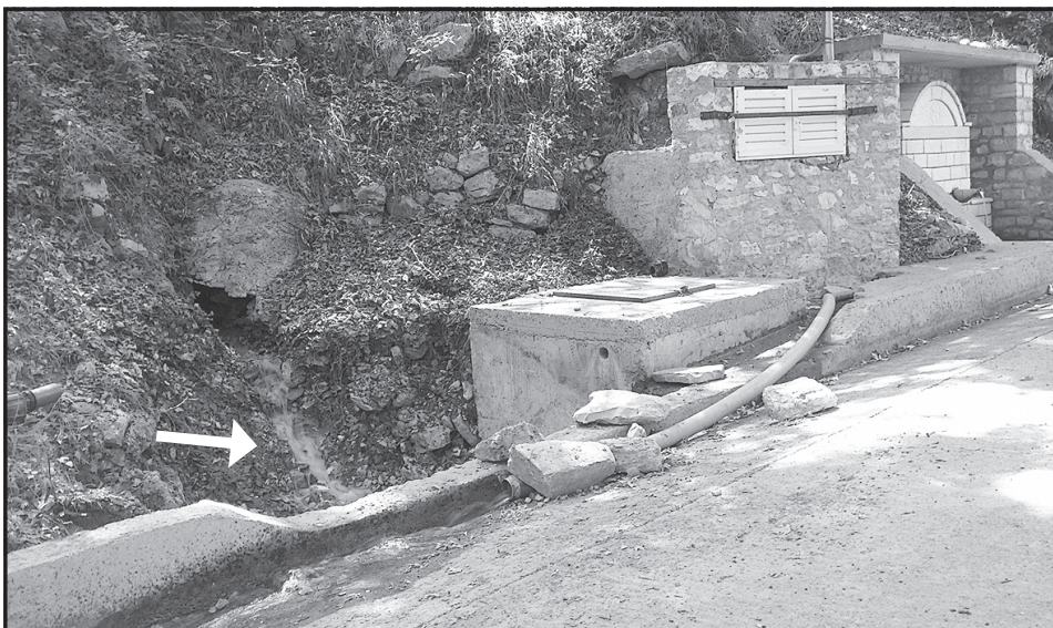
Νέα πηγή (στο βελάκι φαίνεται η θέση που θα κατασκευαστεί η νέα δεξαμενή).
