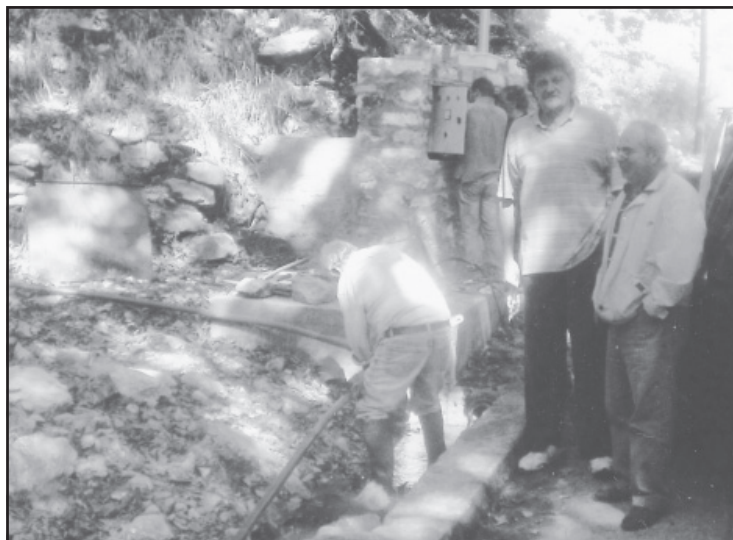
Ο Δήμαρχος Πλατάνου κ. Ανδρέας Δρόσος, επιβλέπει την εγκατάσταση της αντλίας, στην υδρομάστευση της Πηγής Λιμισιά.
