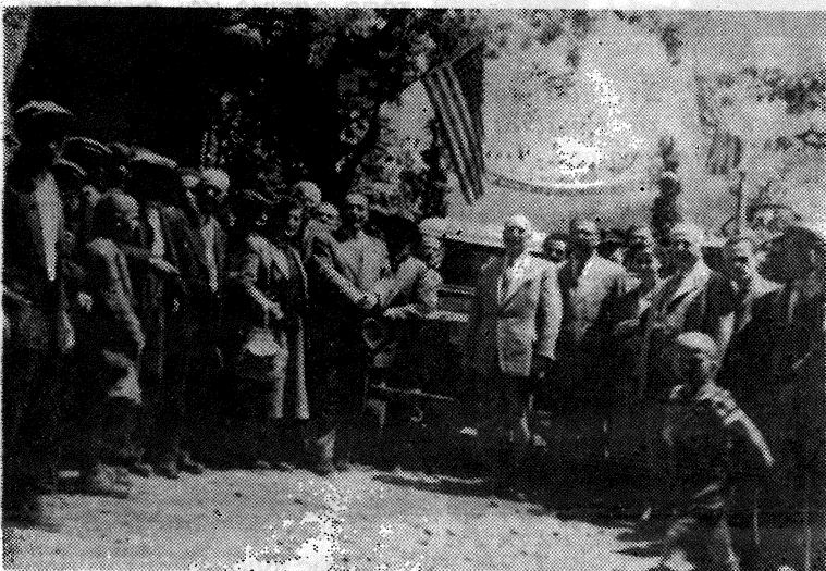
Από την τελετή των εγκαίνιων της αμαξίτης οδού Νεοχωρίου — Δομνίστας, που έγινε στο Νεοχώρι — Ναυπακτίας στις 25 Μαΐου 1952.
